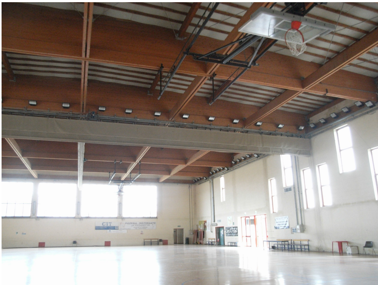
Vista interna della palestra in direzione nord-est
