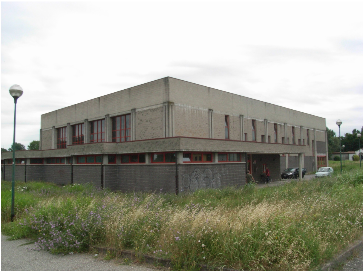
FOTO 2 – Vista dei prospetti nord ed ovest
