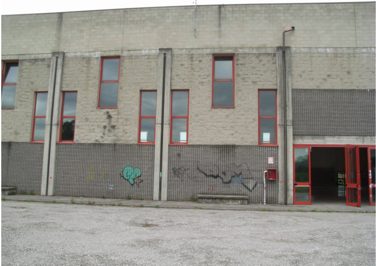
FOTO 4 – Dettaglio del prospetto est
