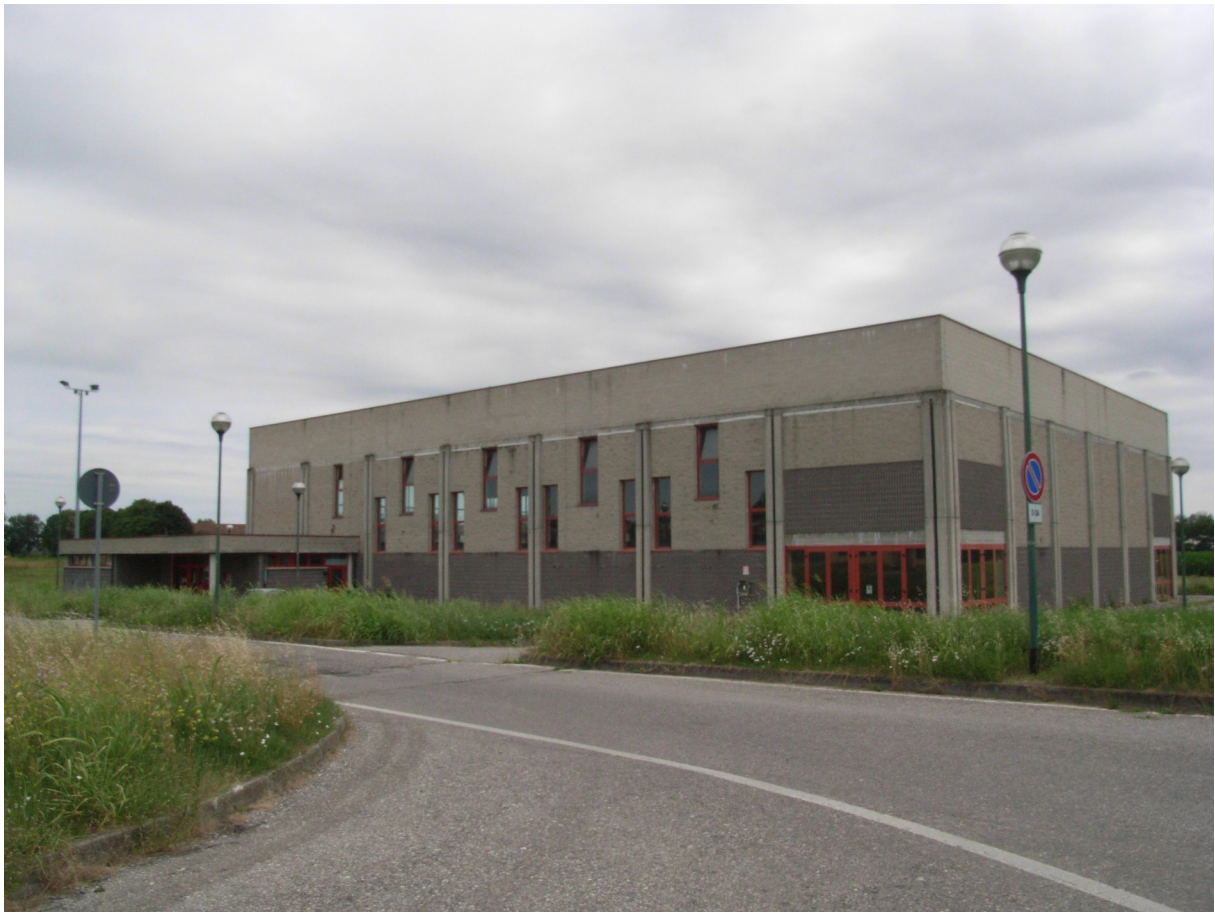
FOTO 1 – Vista dei prospetti ovest e sud
