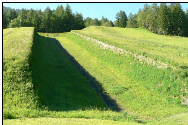
Interventi di inerbimento con idrosemina (prima fase a sinistra, seconda fase a destra)
