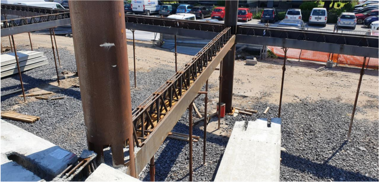
Foto n. 6 – Porzione di solaio in fase di completamento
