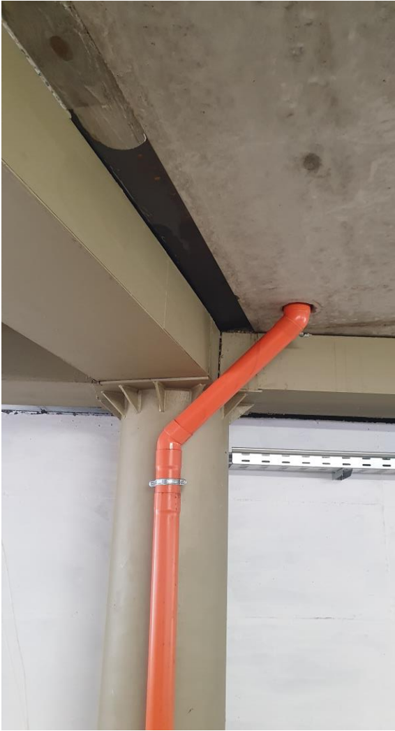
FOTO N. 10 – Dettaglio finitura antincendio
