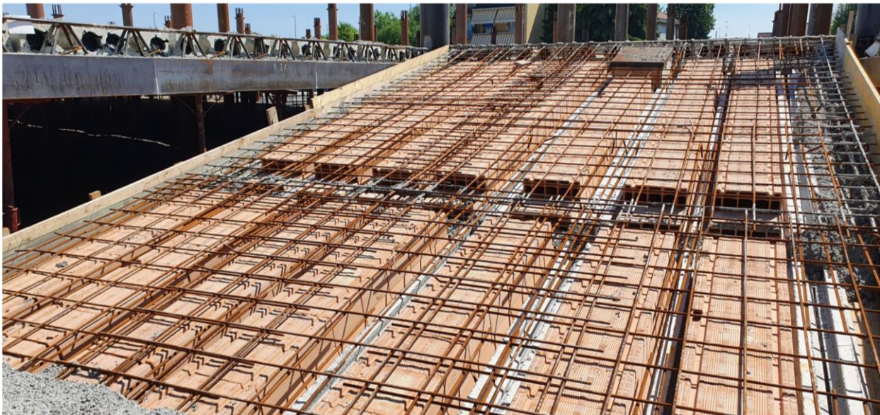
Foto n. 7 – Solaio rampa di accesso
