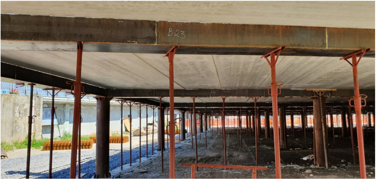
Foto n. 8 – Vista intradosso solaio – puntellazione travi
