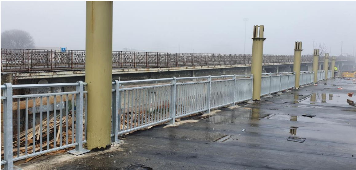
FOTO N. 1 – Parapetto lato ovest
