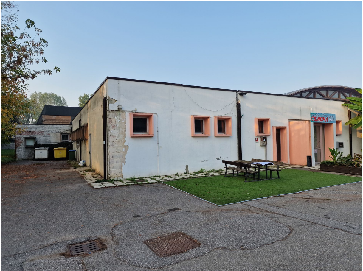
Vista dell'ingresso dell'impianto
