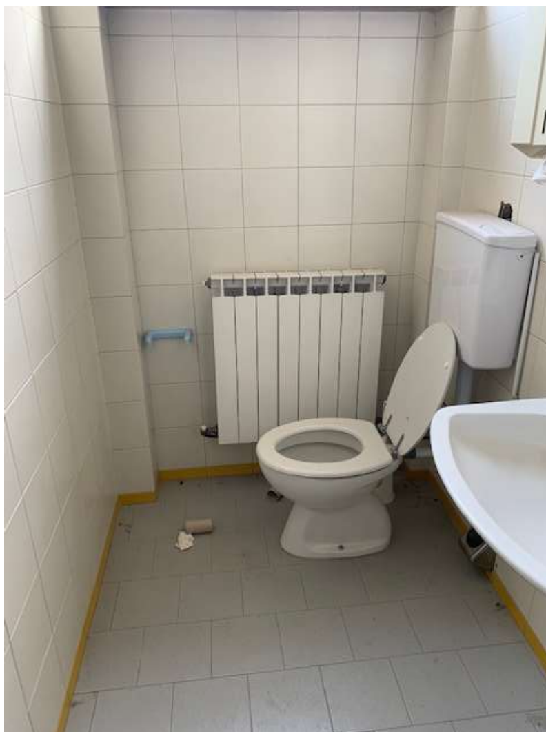
FIGURA 2: RADIATORI IN ALLUMINIO
