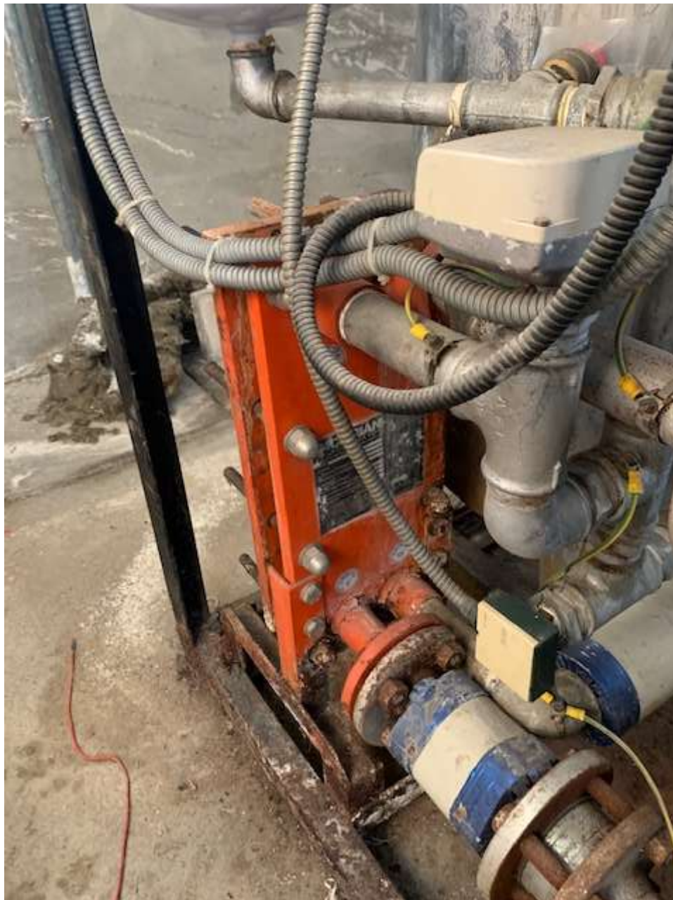
FIGURA14: SCAMBIATORE PER LA PRODUZIONE DI ACS
