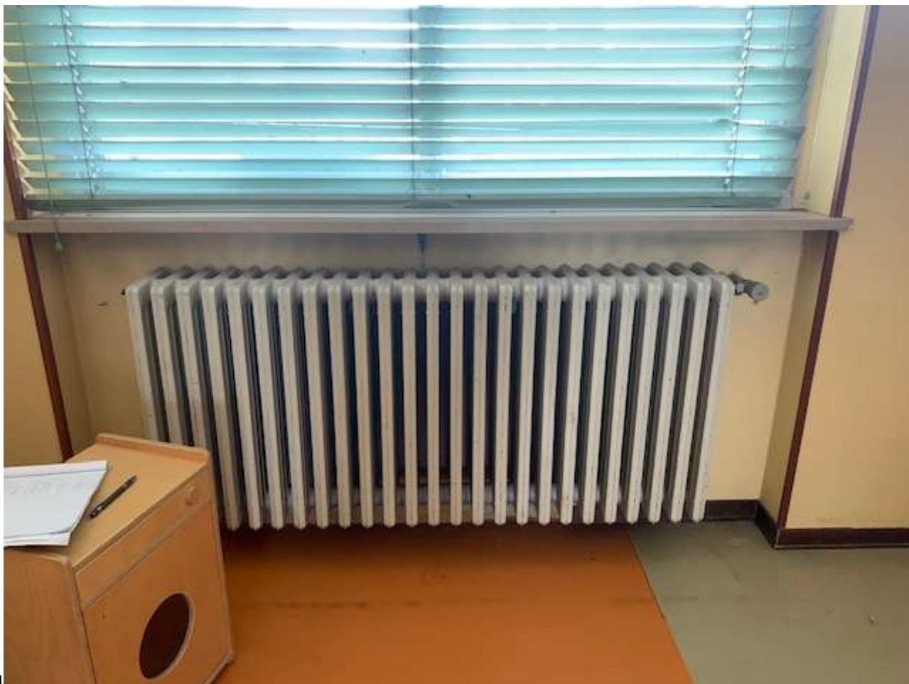
FIGURA 14: RADIATORI TIPOLOGIA 1 IN GHISA
