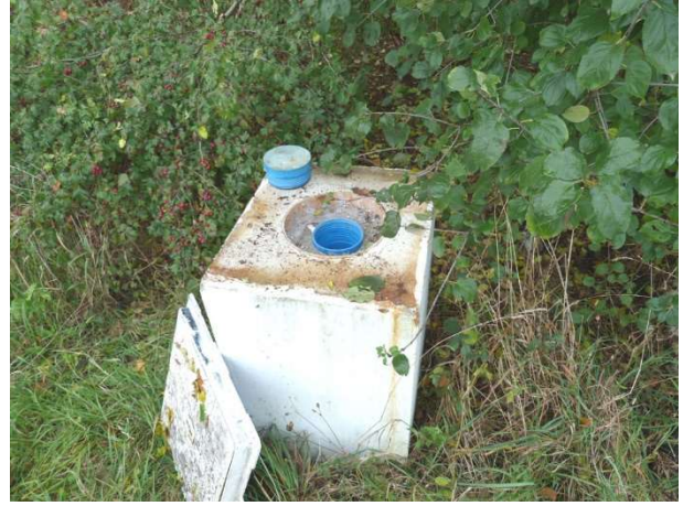
Piezometro monitoraggio ambientale AEM (id. 12)
