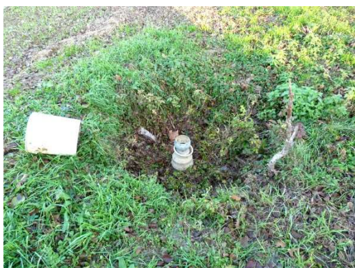
Pozzetto agricolo aperto, senza pompa propria (id. 26)
