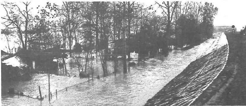
L'argine vicino al bar Manola: i rami sono stati incastrati forati di cemento nel terreno
