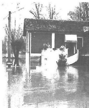
Il ristorante Pescatore a Castalvetto parzialmente sommerso dalle acque
