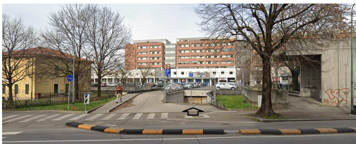
L'accesso, precluso, da via Mantova al piano interrato.
