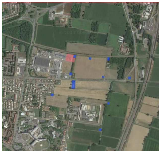
Campo pozzi "ovest" e potabilizzatore
