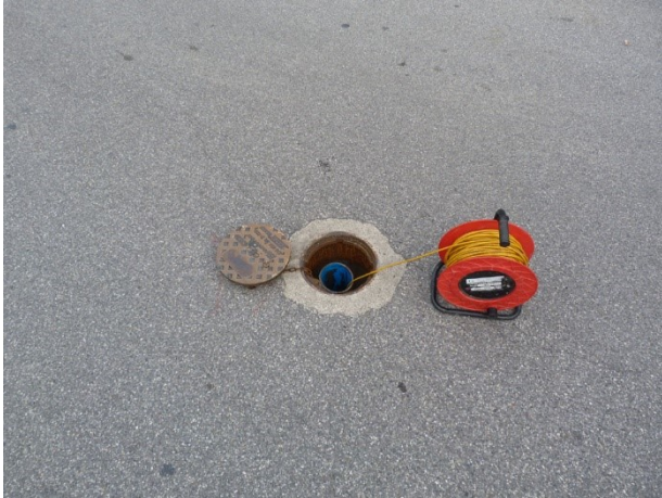
Piezometro monitoraggio ambientale (id.27)
