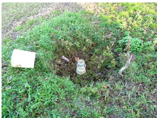
Pozzetto agricolo aperto, senza pompa propria (id. 26)
