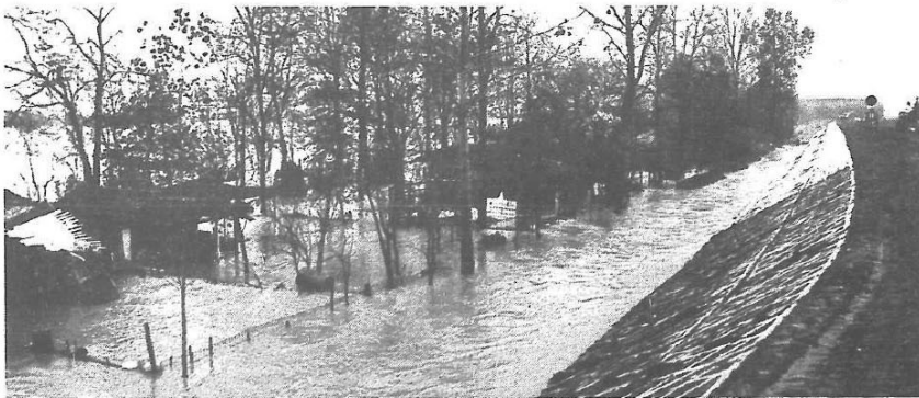
L'argine vicino al bar Manola: ieri sono stati incastrati torati di cemento nel terreno
