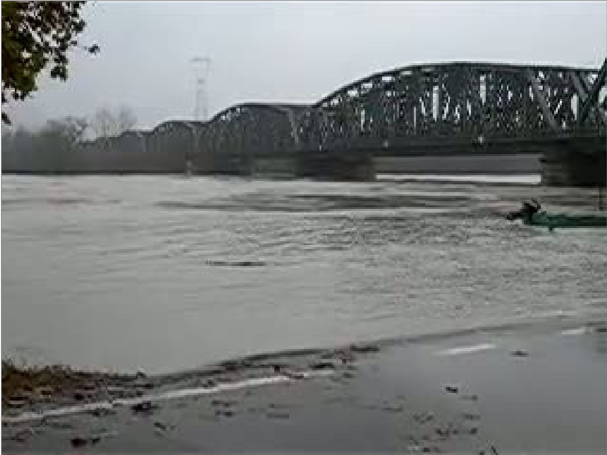
la piena del Po al ponte ferroviario di Cremona
