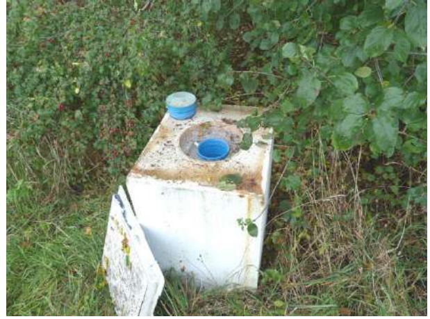
Piezometro monitoraggio ambientale AEM (id. 12)
