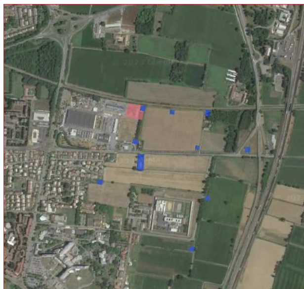
Campo pozzi "ovest" e potabilizzatore
