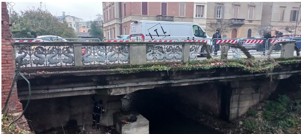
fig. 15. Ripresa del ponte – vista della soletta a sbalzo
