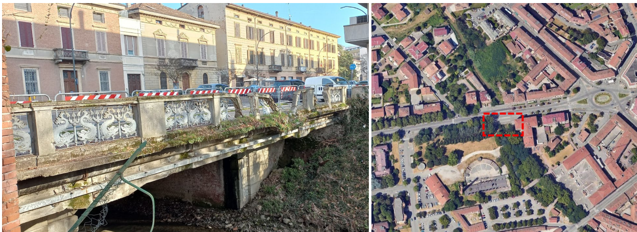
fig. 1. Vista del manufatto oggetto d'intervento e vista area
