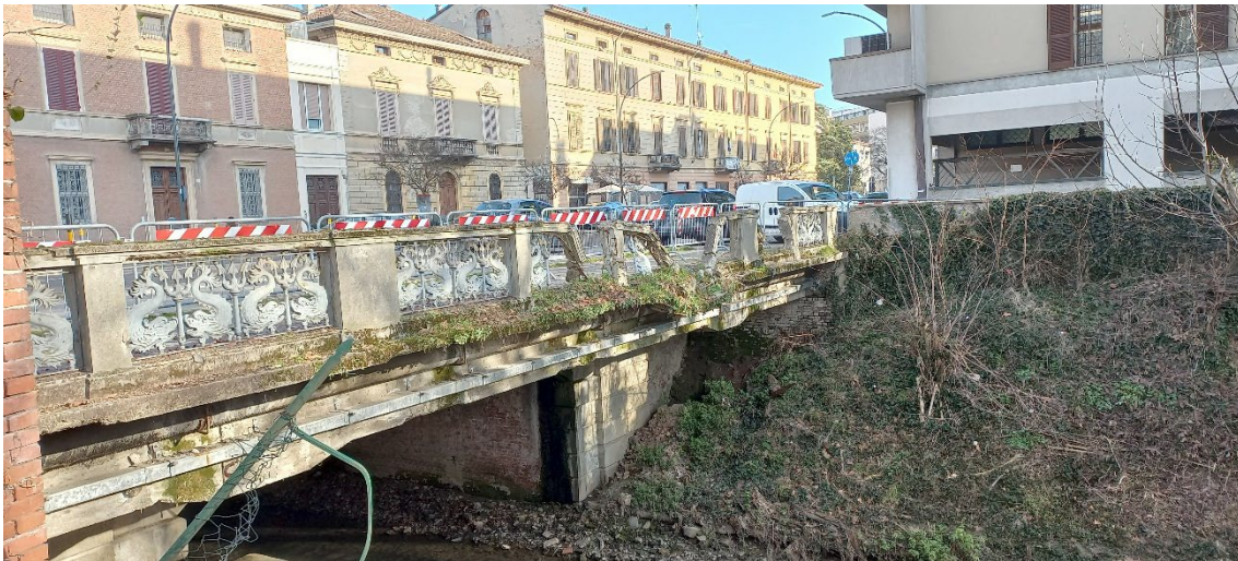
Figura 2. Vista del ponte dal Cavo Morbasco
