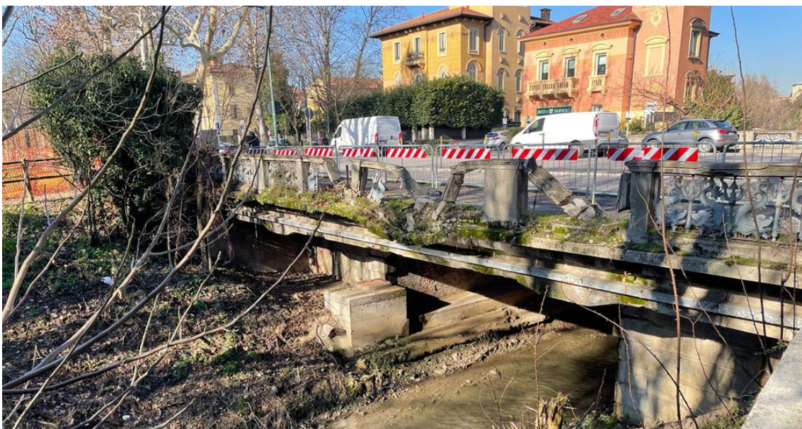
Figura 3. Vista del ponte dal Cavo Morbasco
