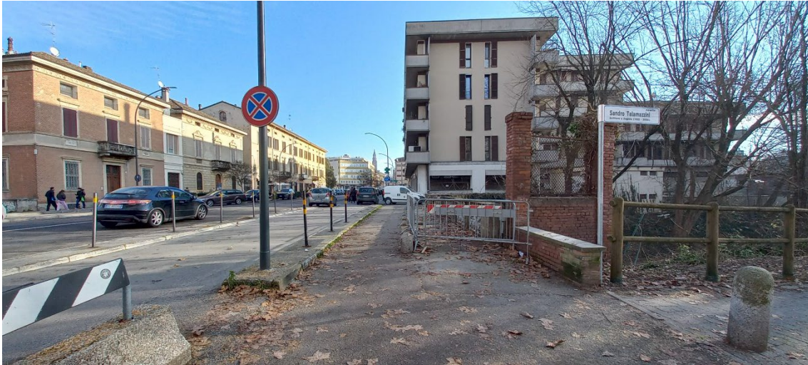
Figura 1. Vista del ponte dal percorso pedonale di Viale Po
