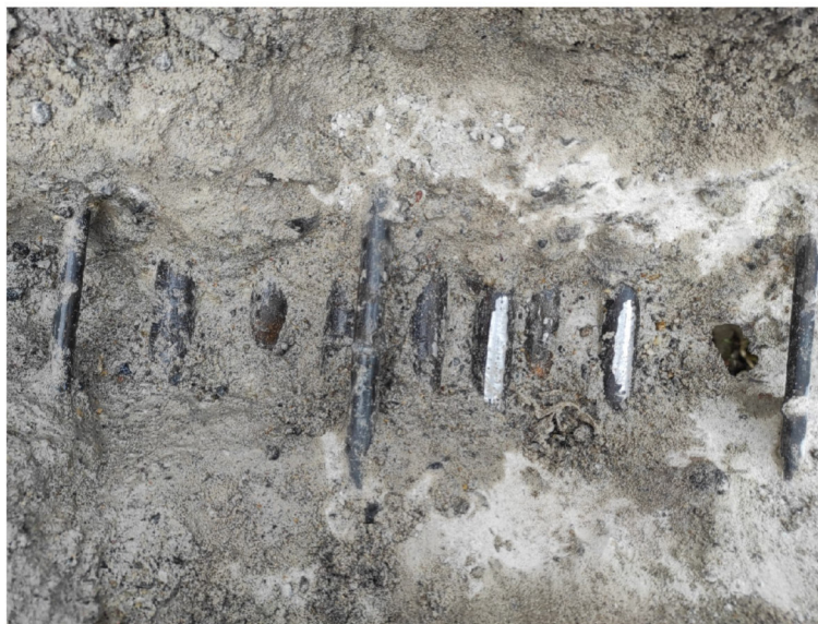
Scasso estradosso eseguito a 3m dal parapetto: n. 2 \varnothing 26 che piegano verso la trave perimetrale
