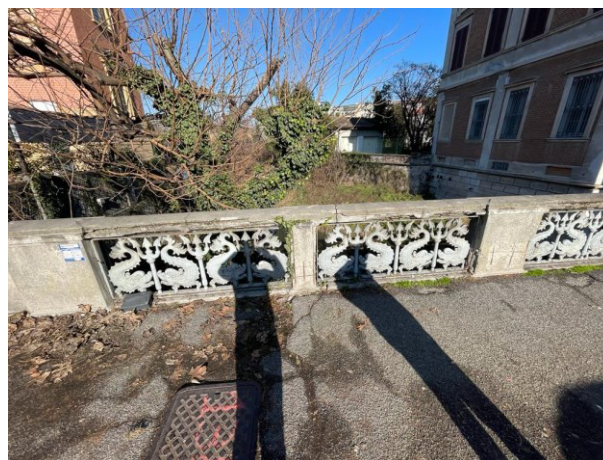
Figura 9 – Sbalzo nord (non oggetto di intervento nel presente progetto) - Stato di fatto
