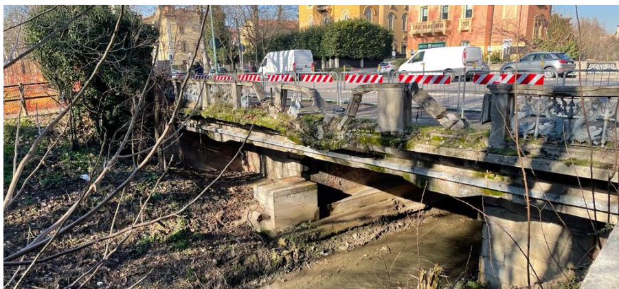
Figura 1 - Stato di fatto
