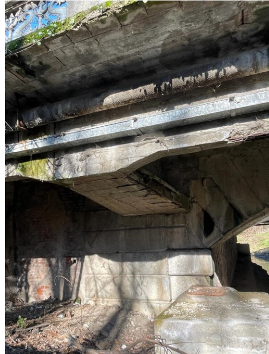
Figura 4 – Viste mensola sud - Stato di fatto
