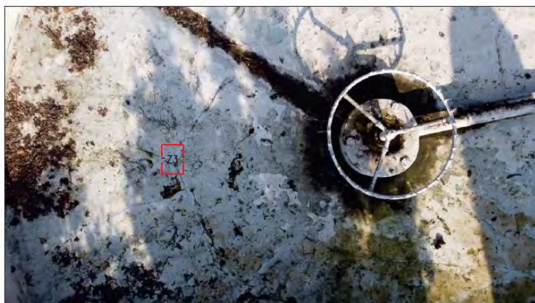
Foto 03 Vista dettaglio fondo vasca
