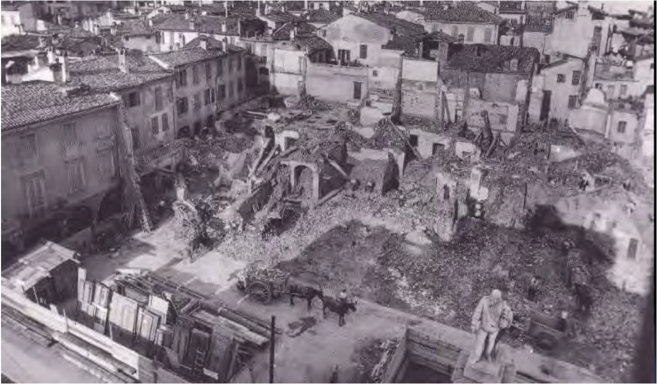
Lavori di demolizione per la realizzazione dei giardini di Piazza Roma, 1875 circa
