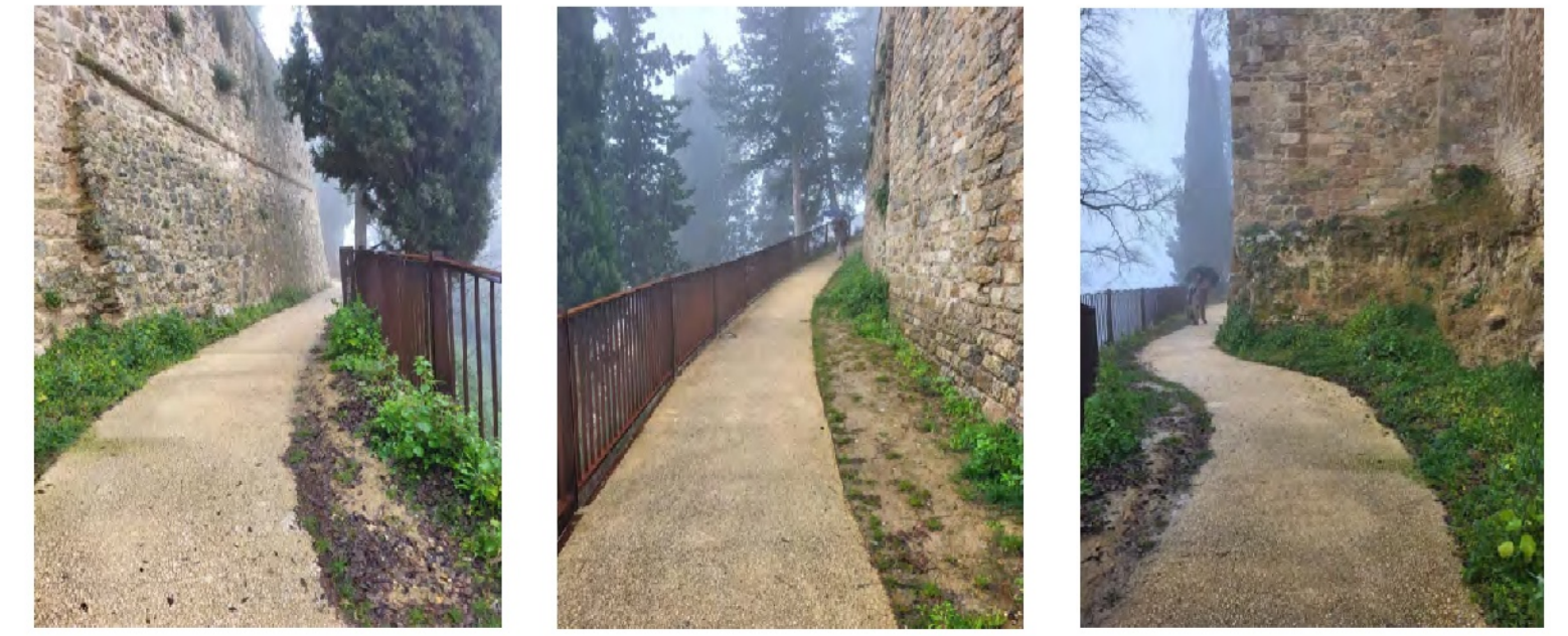
Immagini esemplificative dell'intervento di pavimentazione del percorso che si trova sotto il tratto orientale delle mura di San Giuganone (Sicani), eseguito con miscela stabilizzata di inerti a granulometria differenziata, approvata dopo campionatura dalla Sashp di Anzeo e Siena (Progetto e Direzione Lavori Alberta Chiari, Flavio Cassarino e Lorenzo Jurina - 2023)
