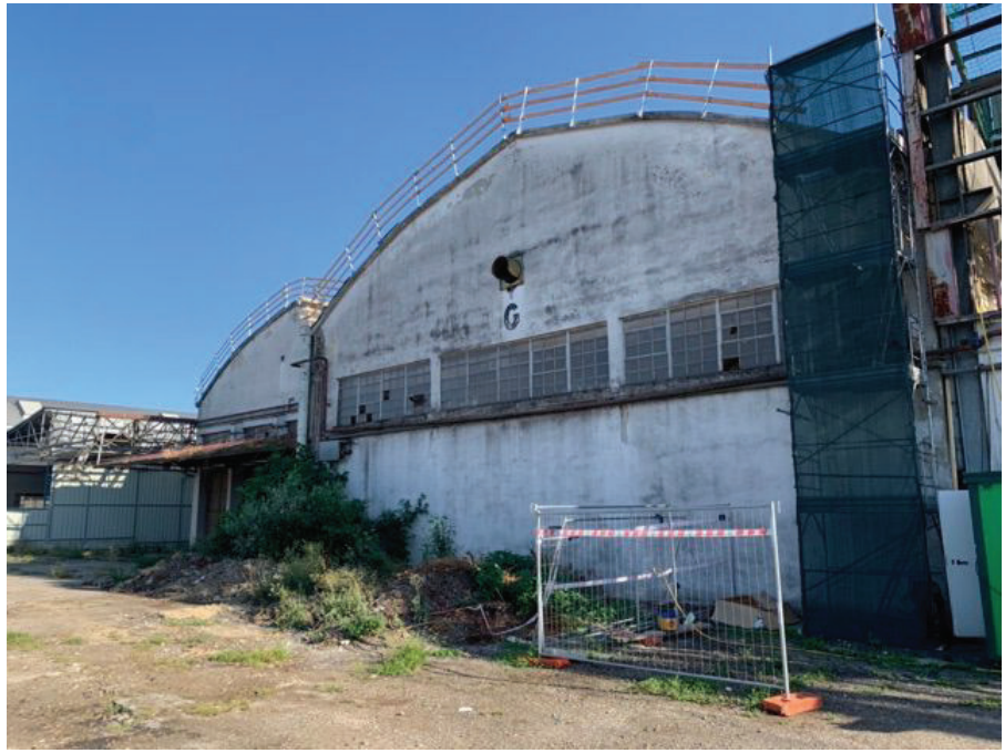
Vista capannone 1 da esterno
