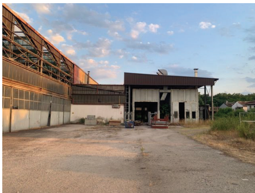
Vista dell'area in esame (capannoni dismessi)
