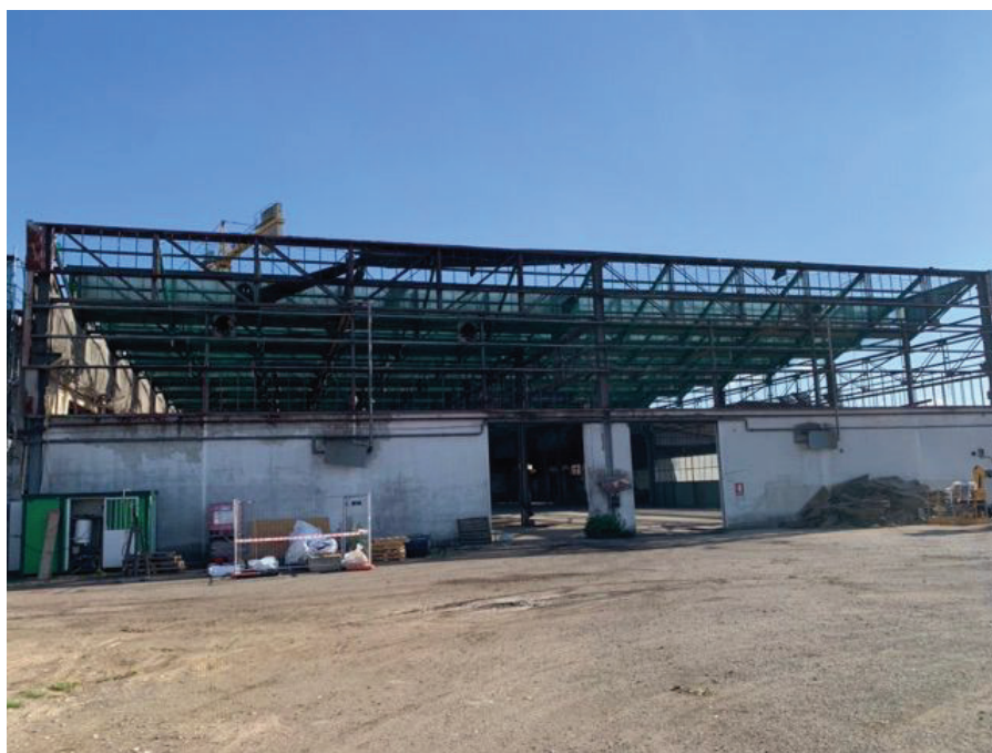
Vista capannone 2 da esterno
