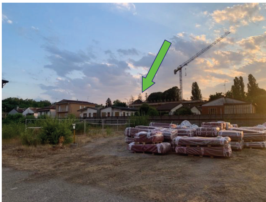
Vista recettori sensibili dall'interno dell'area
