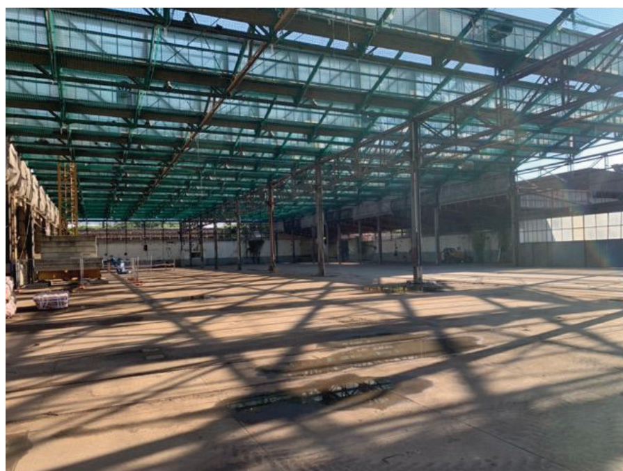
Vista capannone 2 da interno
