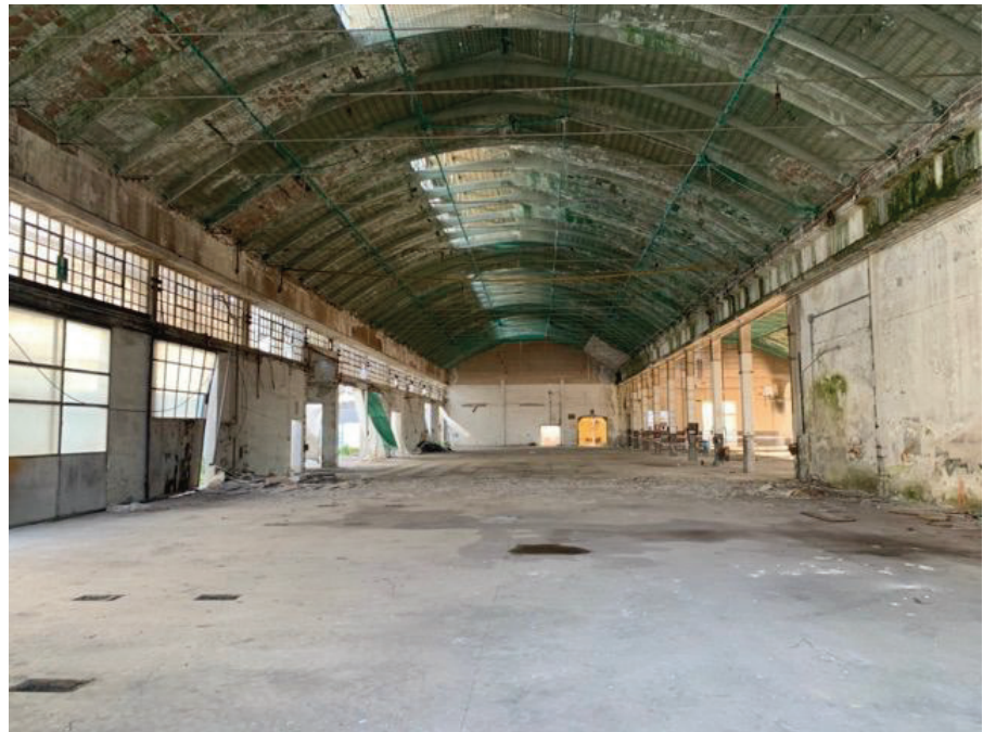
Vista capannone 1 da interno
