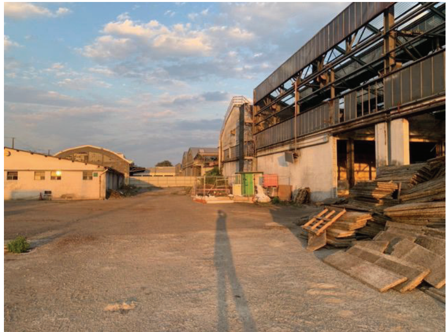
Vista dell'area in esame (capannoni dismessi)
