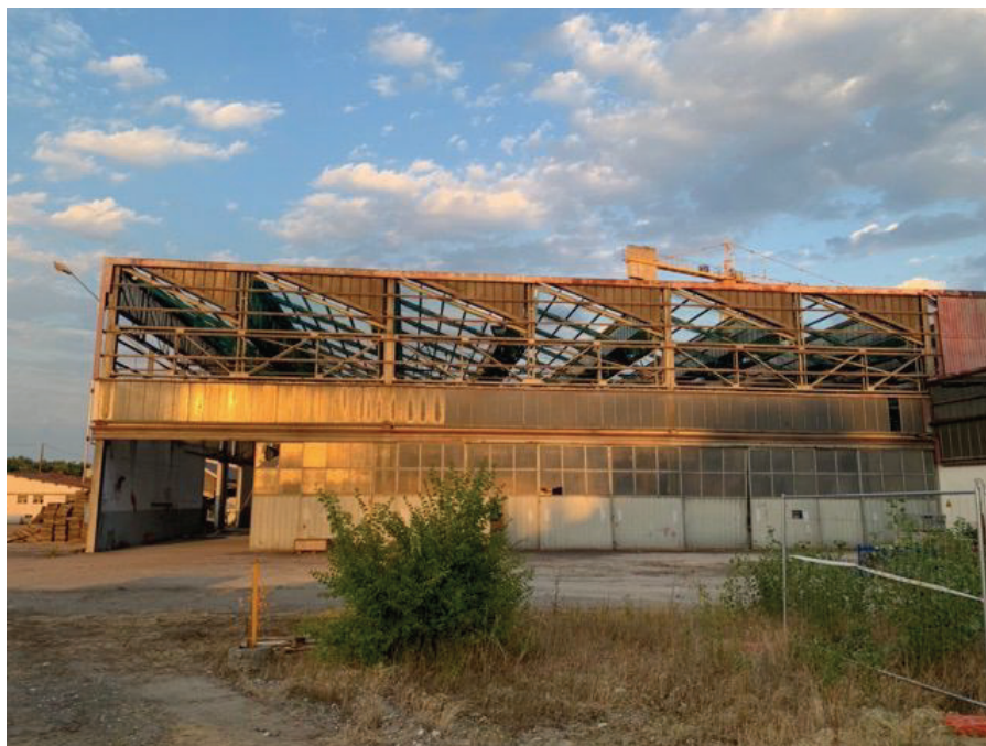
Vista dell'area in esame (capannoni dismessi)
